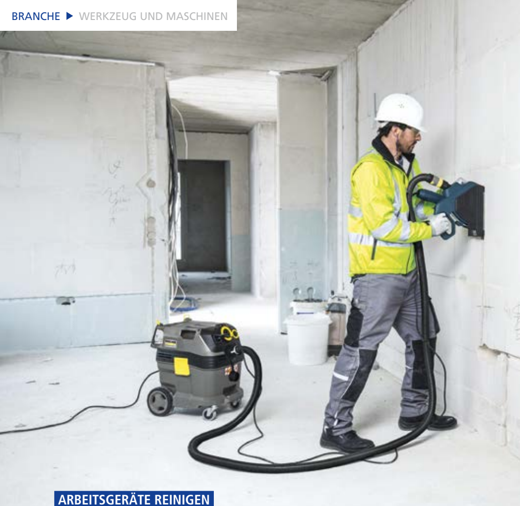
Die nahezu vollständige Feinstaubbeseitigung mit dem NT 30/1 Tact Te M von Kärcher gewährleistet saubere und sichere Arbeitsplätze. (Fotos: Kärcher)
