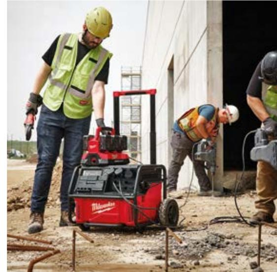
Die mobile Stromversorgung IRPSUOP2500 ist eine leistungsstarke und flexible Lösung, um kabelgebundene Geräte zu betreiben oder Werkzeugakkus direkt auf der Baustelle aufzuladen. (Foto: Milwaukee)
