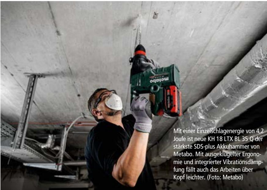
Mit einer Einzelschlagenergie von 4,2 Joule ist neue KH 18 LTX BL 35 Q der stärkste SDS-plus Akkuhammer von Metabo. Mit ausgeklügelter Ergonomie und integrierter Vibrationsdämpfung fällt auch das Arbeiten über Kopf leichter. (Foto: Metabo)
