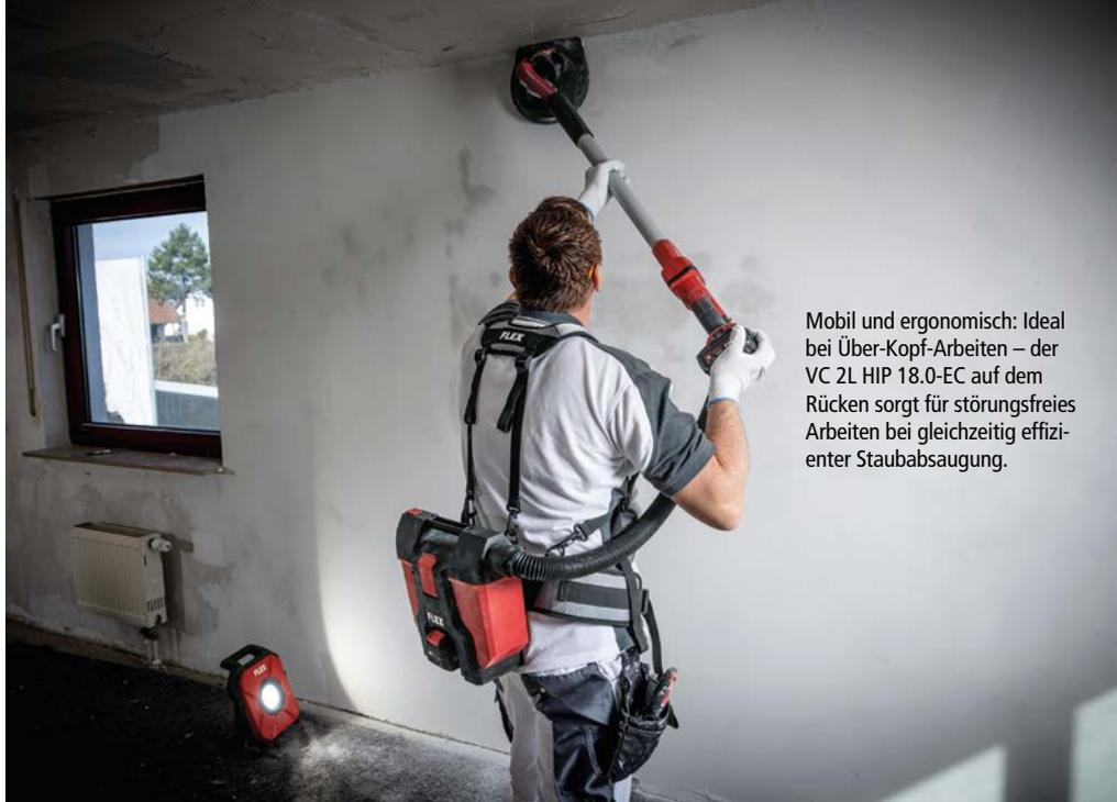
Mobil und ergonomisch: Ideal bei Über-Kopf-Arbeiten – der VC 2L HIP 18.0-EC auf dem Rücken sorgt für störungsfreies Arbeiten bei gleichzeitig effizienter Staubabsaugung.
