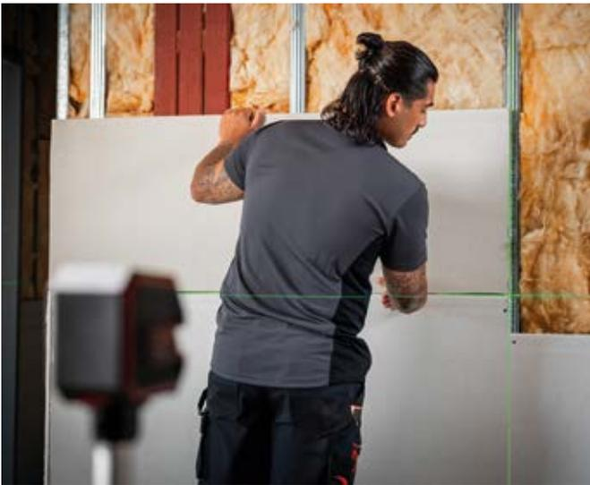
Der X2 Green projiziert zwei präzise Laserlinien in einem exakten 90°-Winkel. (Foto: Sola-Messwerkzeuge GmbH)
