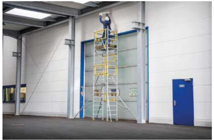
Das Ein-Personen-Gerüst FlexTower der Munk Günzburger Steigtechnik ermöglicht ergonomische Arbeiten in der Höhe.
