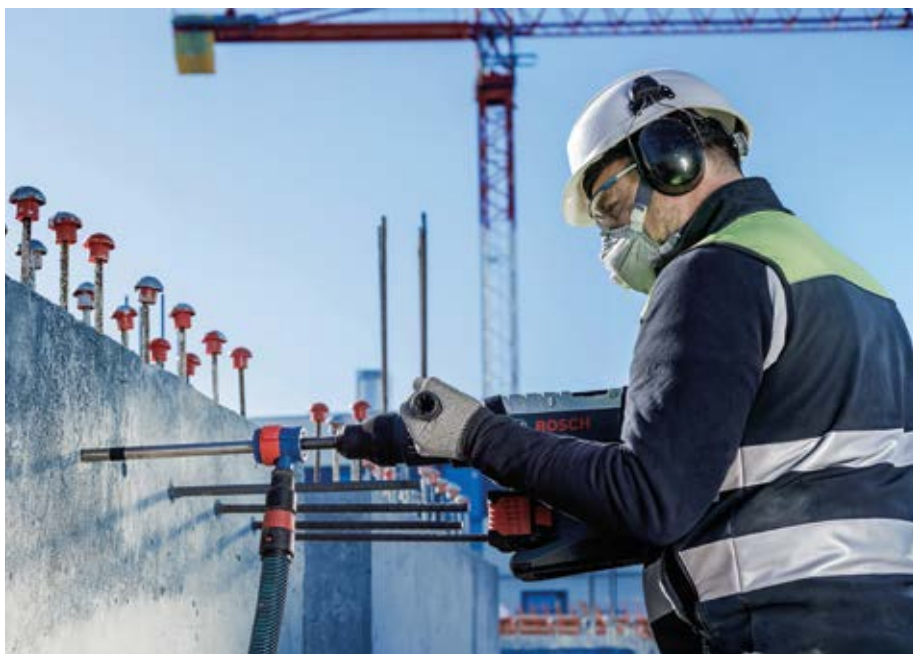
Die neuen Absaugbohrer Expert SDS Clean plus-8X und SDS Clean max-8X aus dem Expert-Zubehörprogramm von Bosch sorgen für eine bis zu 25-mal bessere Staubentfernung als das Pendant ohne Staubabsaugung.
