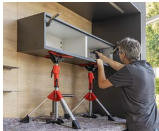
Die kürzeste Version der Deckenstütze STE ist ebenfalls einhändig bedienbar und besonders hilfreich beim Küchen- und Ladeneinbau. (Foto: Bessey)
