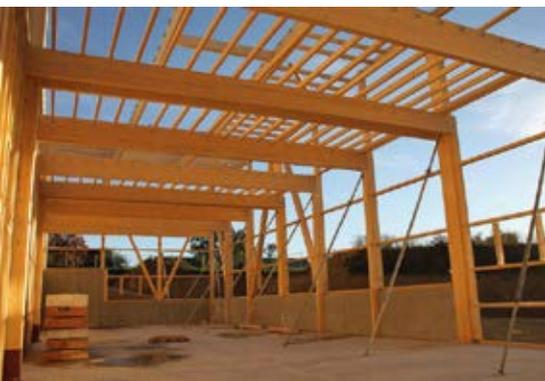
Für die Wände von Halle 2 wurde ein Holzrahmenbau aufgestellt. Die Handwerker setzten hier auf Tellerkopfschrauben vom Typ Heco-Topix-plus 8,0 x 200. Damit verschraubten sie die Holzstreben in den Wandelementen.
