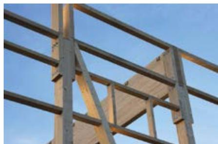
Die Halle wurde in Holzbauweise errichtet – lediglich ein paar Stahlbauteile wurden aus statischen Gründen benötigt.
