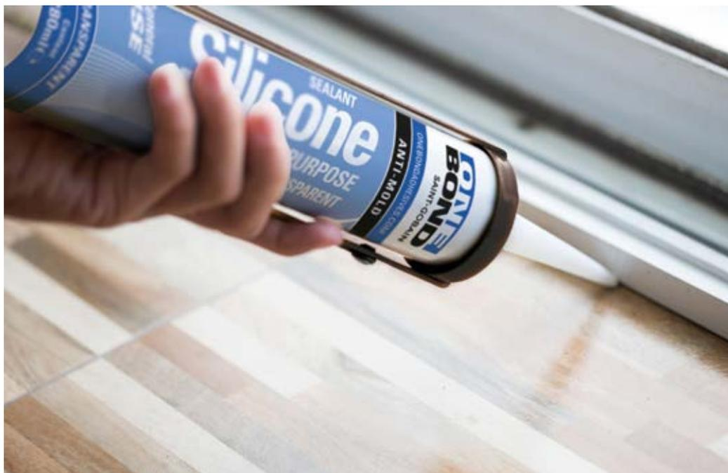
Zu den Einsatzbereichen des einkomponentigen Mehrzweck-Acetoxy-Dichtstoffs gehören Fensterrahmen (innen) ebenso wie zum Beispiel Küchenrückwände oder Arbeitsplatten. Mit dem weißen beziehungsweise transparenten Dichtstoff lassen sich Abdichtungen mittels Silikonpistole sicher und mühelos realisieren. (Fotos: Saint-Gobain Abrasives GmbH)
