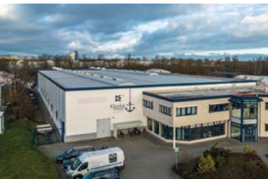
Kloska-Standort an der Straße „Zum Kühlhaus“ in Rostock. (Fotos: Meta)
