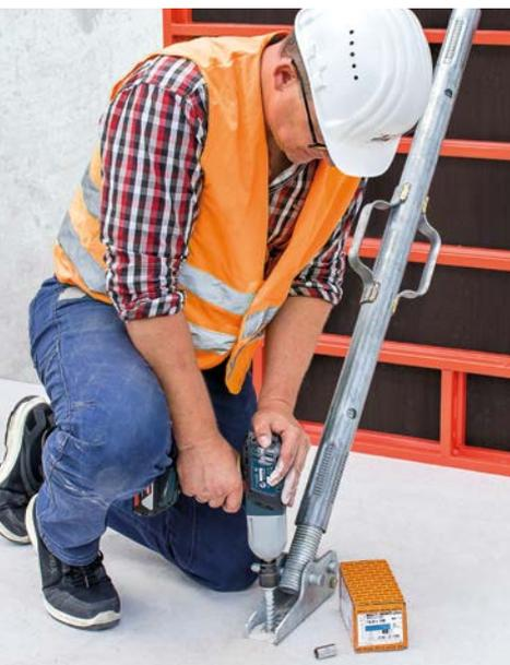
MMS-plus: Das Schraubanker-Sortiment mit den meisten Zulassungen eignet sich unter anderem zur Mehrfachverwendung bei temporären Befestigungen. (Foto: Heco-Schrauben)
