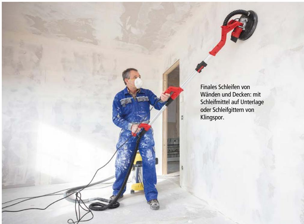
Finales Schleifen von Wänden und Decken: mit Schleifmittel auf Unterlage oder Schleifgittern von Klingspor.
