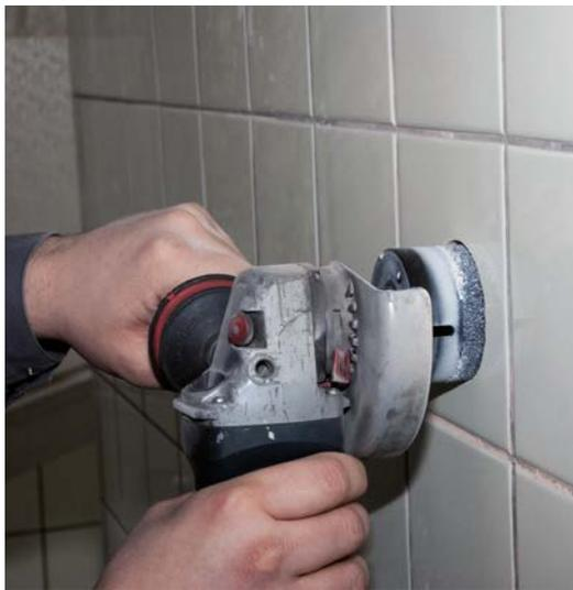
ser noch aus der freien Hand setzen, kommen bei größeren Durchmessern in der Regel Maschinen mit Stativen zum Einsatz. Klingspor liefert selbstverständlich auch für diese großen Durchmesser auf die Standardmaße hin konzipierte Diamantbohrkronen für Nass- ebenso wie für Trockenbohrungen.
