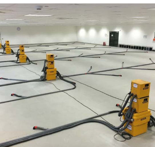
Ein klassisches Einsatzfeld der WILMS Heizgeräte: das Heizen bzw. die Trocknung von Baustellen.
