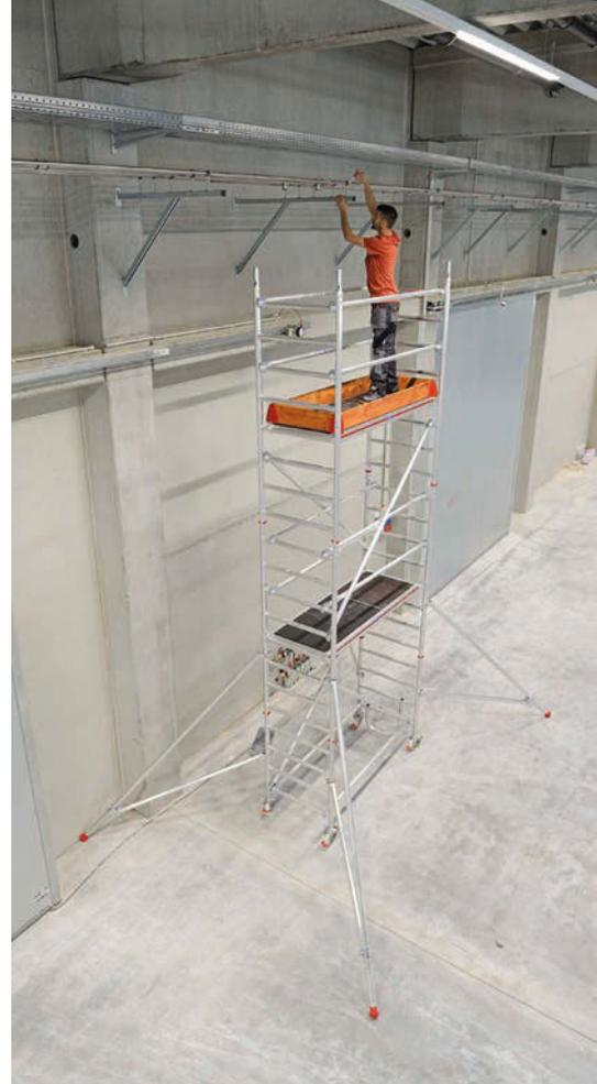
Das Hymer-Fahrgerüste-Programm steht im Jubiläumsjahr besonders im Fokus. Es beinhaltet 15 verschiedene Fahrgerüsttypen. Sämtliche Ausstattungsmerkmale lassen sich dabei bis ins Detail anpassen. Und dies bei variablen Gerüsthöhen von überschaubaren 1,80 bis stattlichen 13 Metern. Teleskopierbare Ausleger und optional verfügbare Sicherheitsgeländer sorgen für maximale Arbeitssicherheit.
