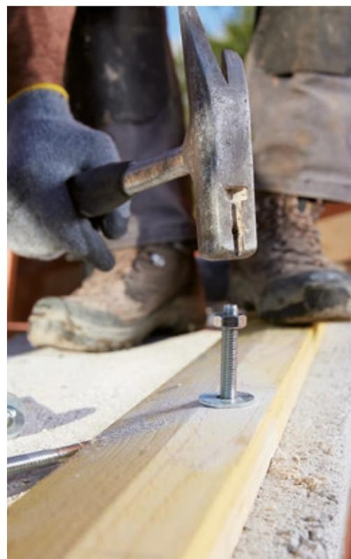
Der Bolzenanker Spit FIX Z Xtrem LW hat eine Europäische Technische Bewertung für gerissenen und ungerissenen Beton. (Foto: ITW Befestigungssysteme)
