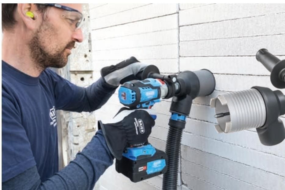
Eintrüsten, entsorgen, reinigen – das Bohren im Nassbetrieb ist immer mit Mehraufwand verbunden. Das gilt für Arbeiten im Rohbau und vor allem in bestehenden Wohn- und Büroräumen. Dort muss das Wasser möglichst komplett abgesaugt werden, um teure Folgeschäden zu vermeiden. Diamant-Trockenbohrmaschinen von Baier eröffnen Handwerkern eine saubere, sichere und wirtschaftliche Alternative für Kernbohrungen in härteste Materialien bis 250 mm Bohrdurchmesser.
